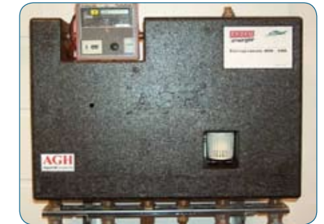
Warmteafleverunit in de meterkast
